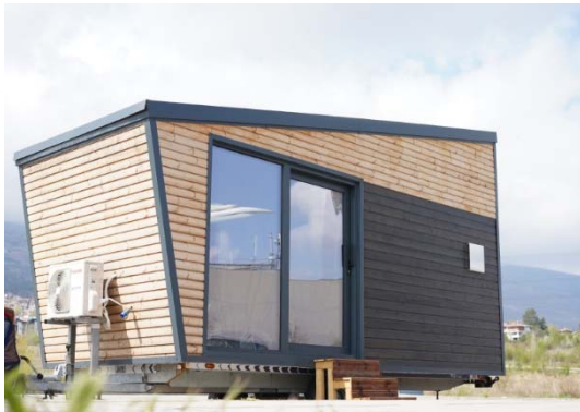
Fig.4. Mobile "Zero Energy Caravan"
